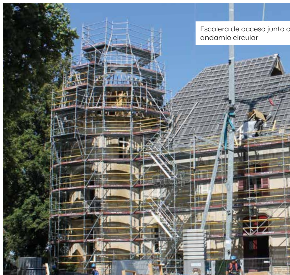
Escalera de acceso acoplada con plataforma de extensión
