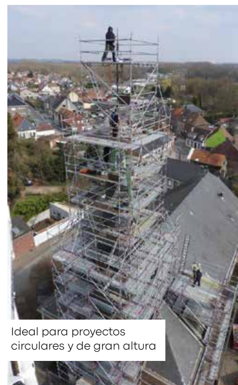
Plataforma de trabajo segura en altura
