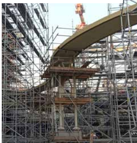
Andamio espacial para cargas de hasta 600 kg/m 2 - clase 6
